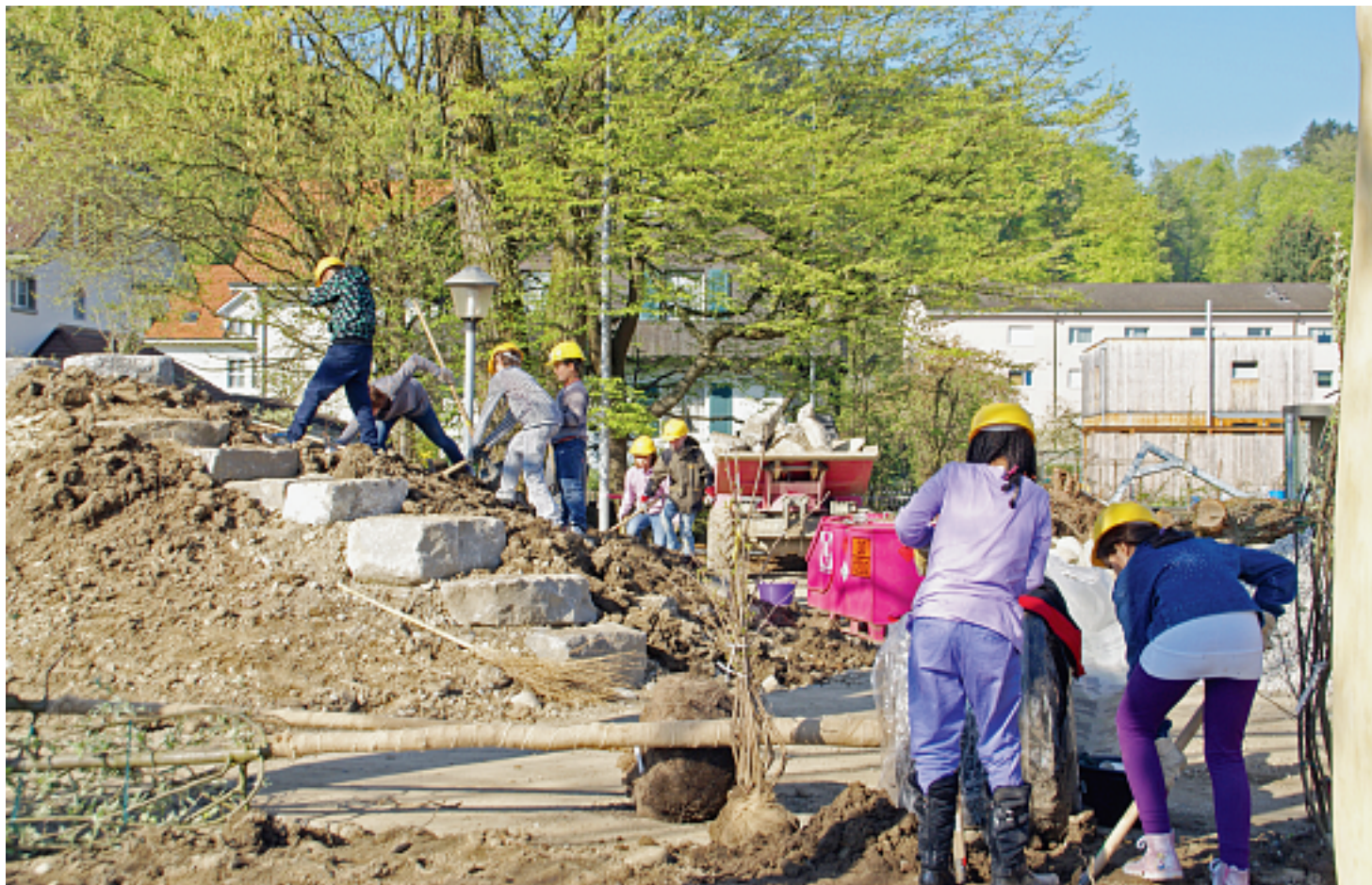
Schaufeln, was das Zeug hält: Bei den Arbeiten in Studen legten auch die kleinen Helfer Hand an – das hatte seine Gründe.
